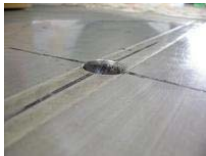
(e) 試験箇所 II のアルミニウム床版上面
