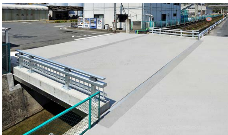
写真3 完成した蒲原ケミカル橋
