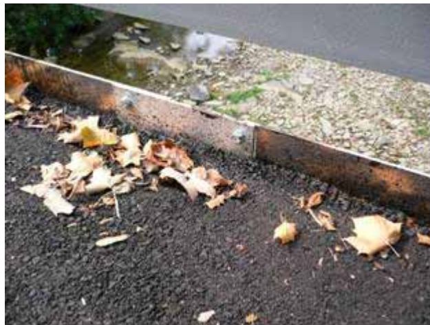
図 - 10 アルミニウム側板の接合
